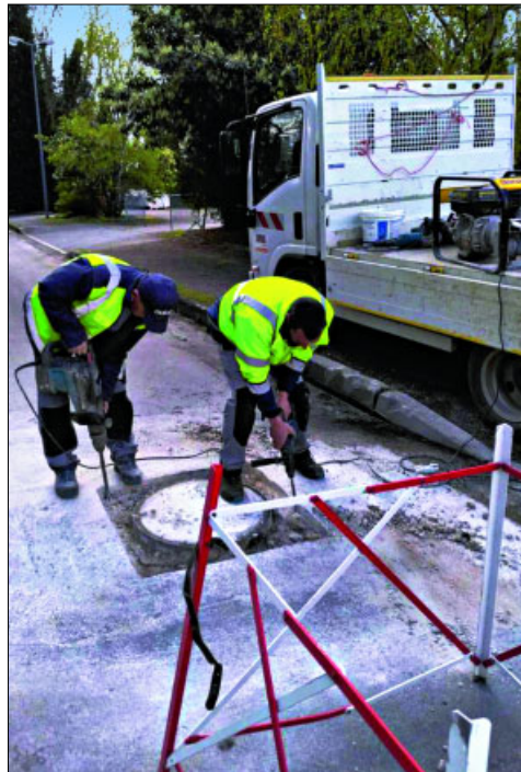
✓ Réparation et scellement d'un regard rue du Moulin.
